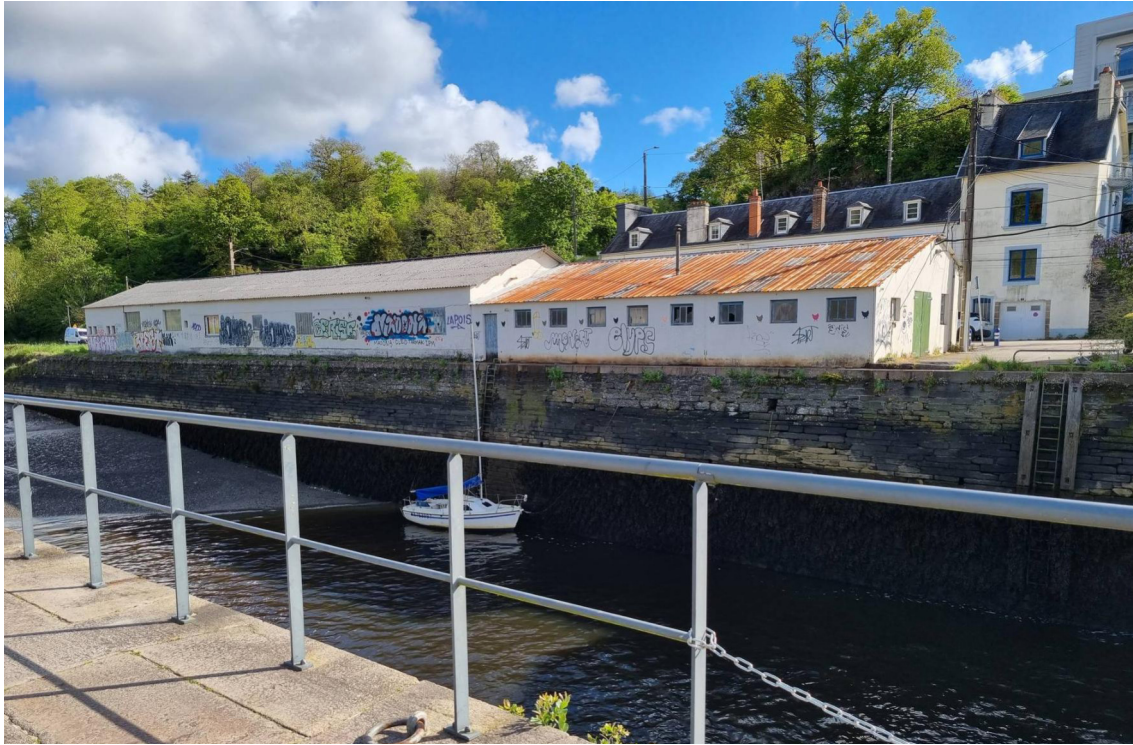
Façade arrière, côté rivière
