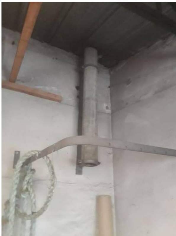
Pièce 12 (Rdc) - Conduit - Fibre ciment
