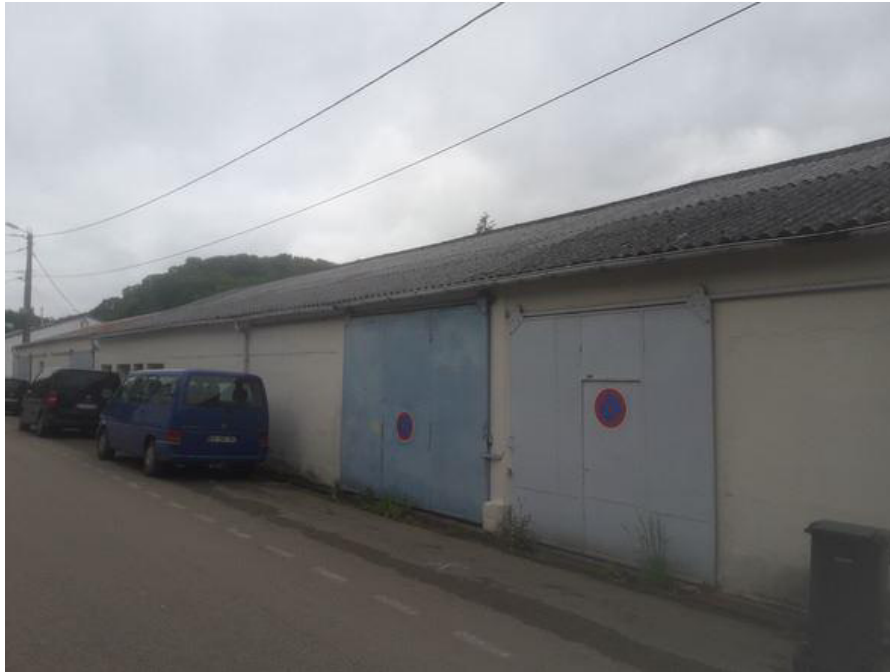
Toiture (Extérieur) - Toiture - Plaque ondulée fibre ciment
